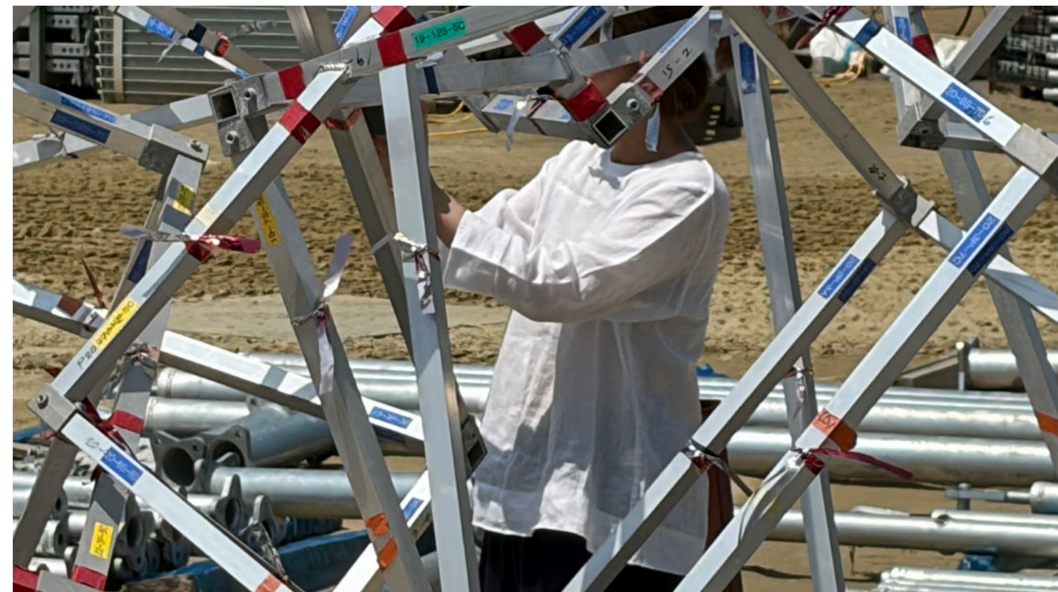
Attention travaux ! © Gabriel Soucheyre
